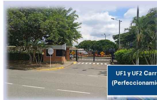
Oficina principal Centro de Control Operacional. Línea de atención: 3113373868
