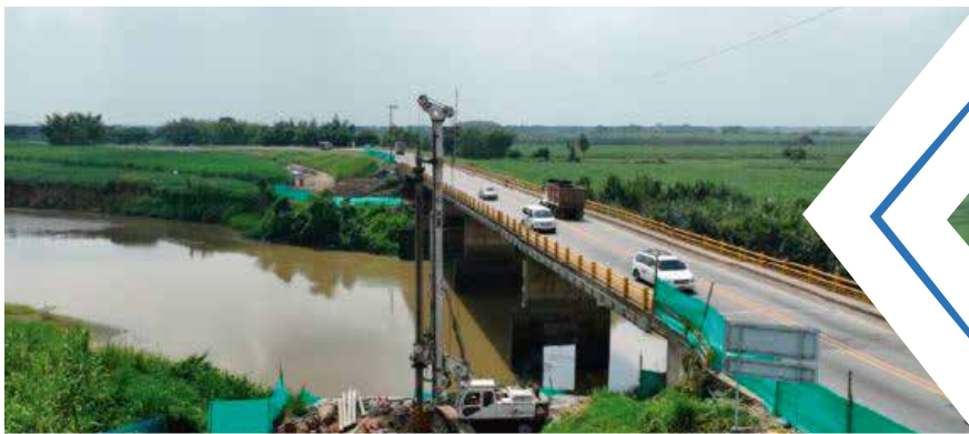
Puente Guillermo Valencia II 13 de los 16 pilotes construidos 80% en cimentación
